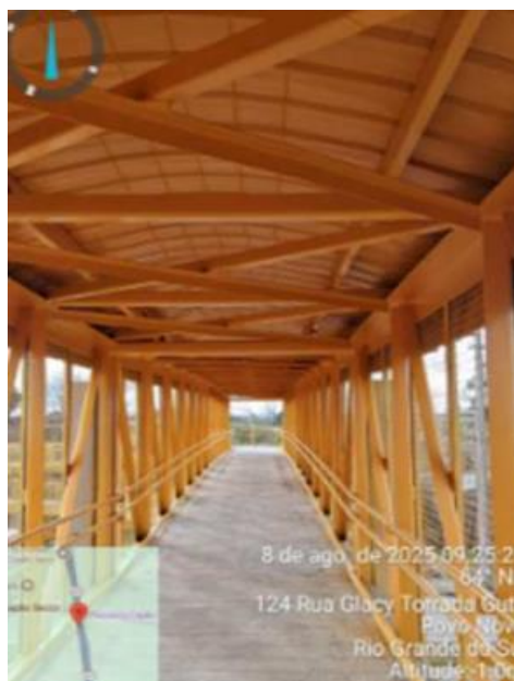
Figura 54. Pintura da estrutura metálica
