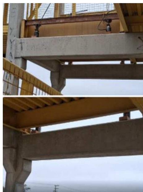
Figura 52. Substituição dos Neoprenes
