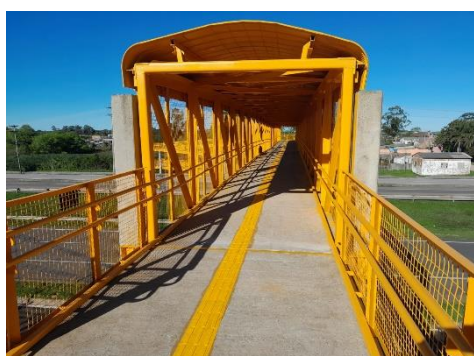
Figura 57. Pintura da estrutura metálica
