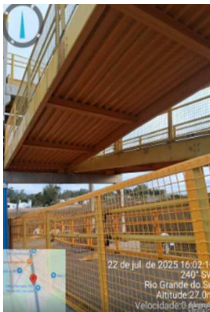
Figura 55. Pintura da estrutura metálica
