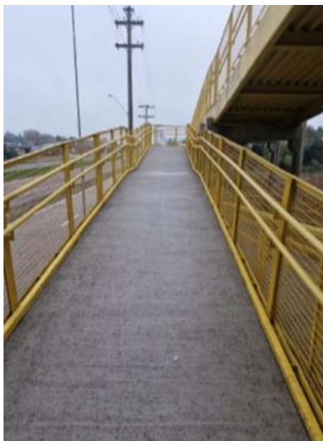
Figura 49. Hidrojateamento das rampas e estruturas metálicas
