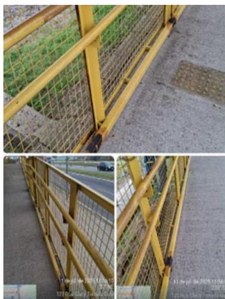
Figura 51. Lixamento e tratamento das ferrugens.
