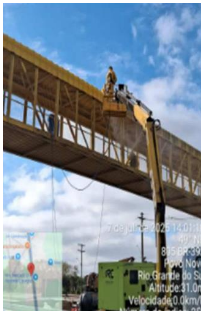
Figura 48. Hidrojateamento da estrutura superior
