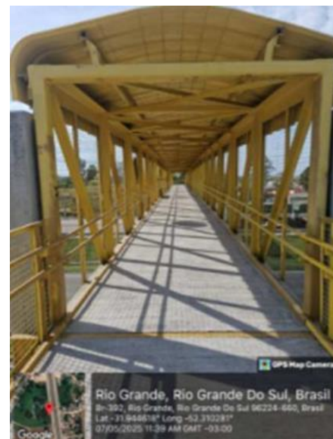
Figura 50. Hidrojateamento das estruturas metálicas
