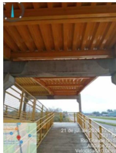
Figura 56. Pintura da estrutura metálica
